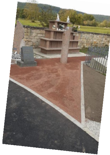
Réfection de l'allée centrale du cimetière.
