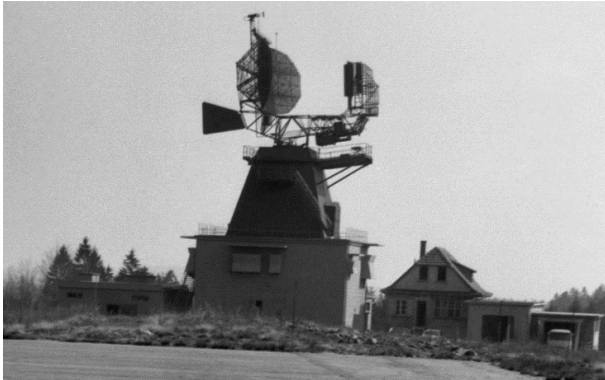
Construction du radar ARES en 1970
