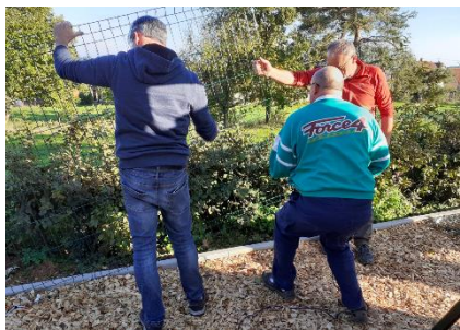
Installation d'un grillage à l'aire de jeux. Un grand merci aux bénévoles !
