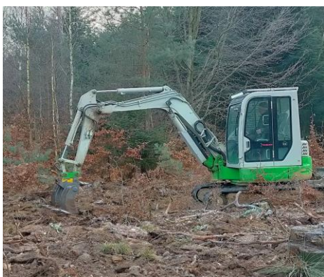
Travail de scarification à la pelle fourche
